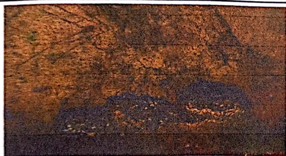
Foto 3: Se observa Deterioro completo en el piso
